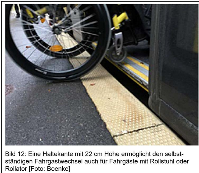
Bild 12: Eine Haltekante mit 22 cm Höhe ermöglicht den selbstständigen Fahrgastwechsel auch für Fahrgäste mit Rollstuhl oder Rollator [Foto: Boenke]
