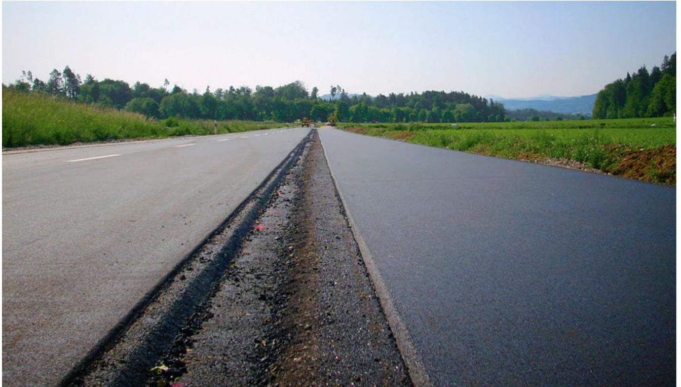
1 | Am Beispiel realisierter Radweg-Bauprojekte wurde ein Variantenvergleich für die Ausführung mit AC T und mit AFK erstellt: Auf der Abbildung gut sichtbar ist der Unterschied zwischen der konventionellen Tragschicht unter der Strasse (links) und des AFK unter dem Radweg (rechts) (Foto: Tiefbauamt Kanton Zürich).
